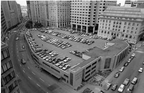
Post Office Square Boston: oude situatie met parkeergarage
